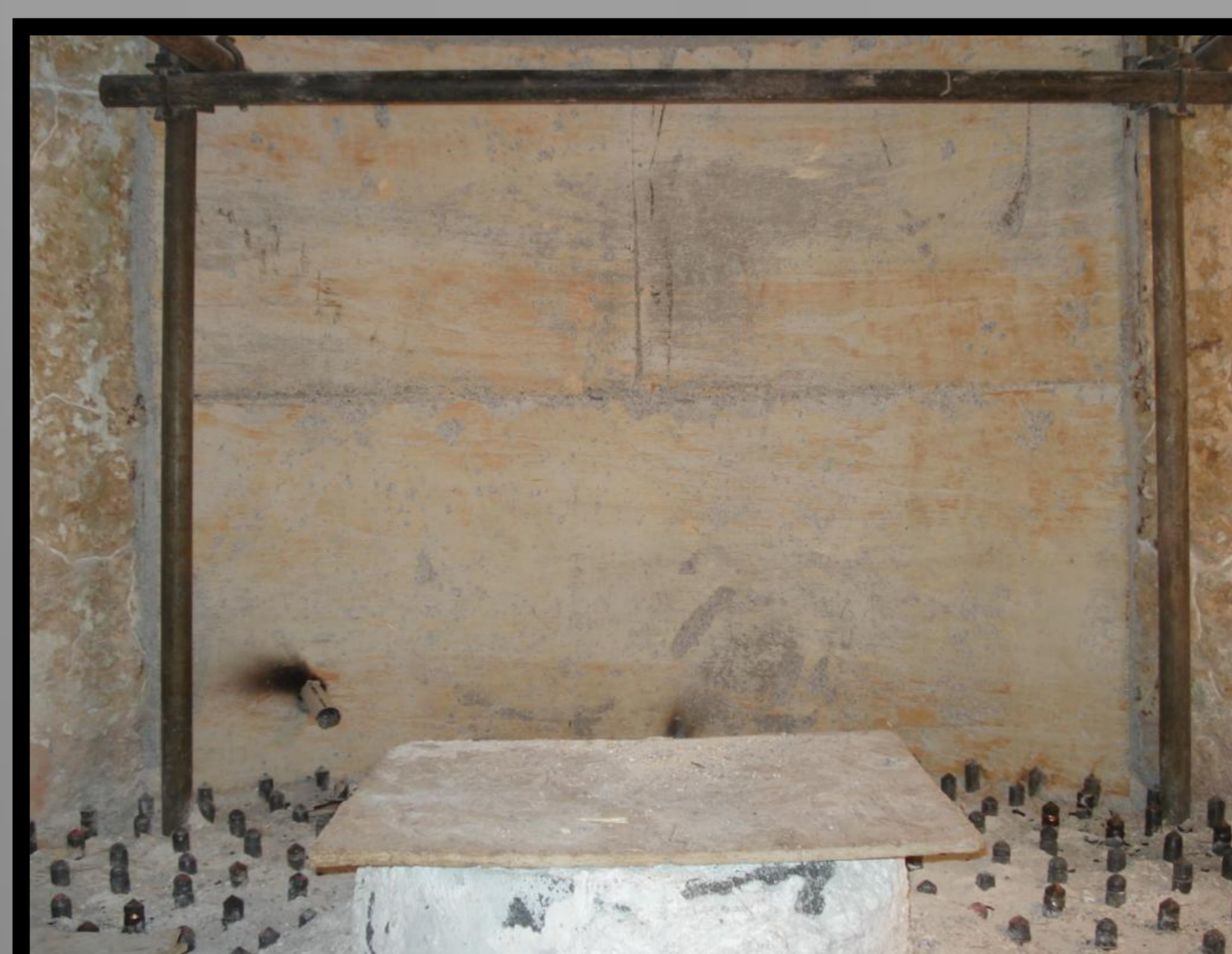
Fig # 6 – Área com aplicação para reparos.
