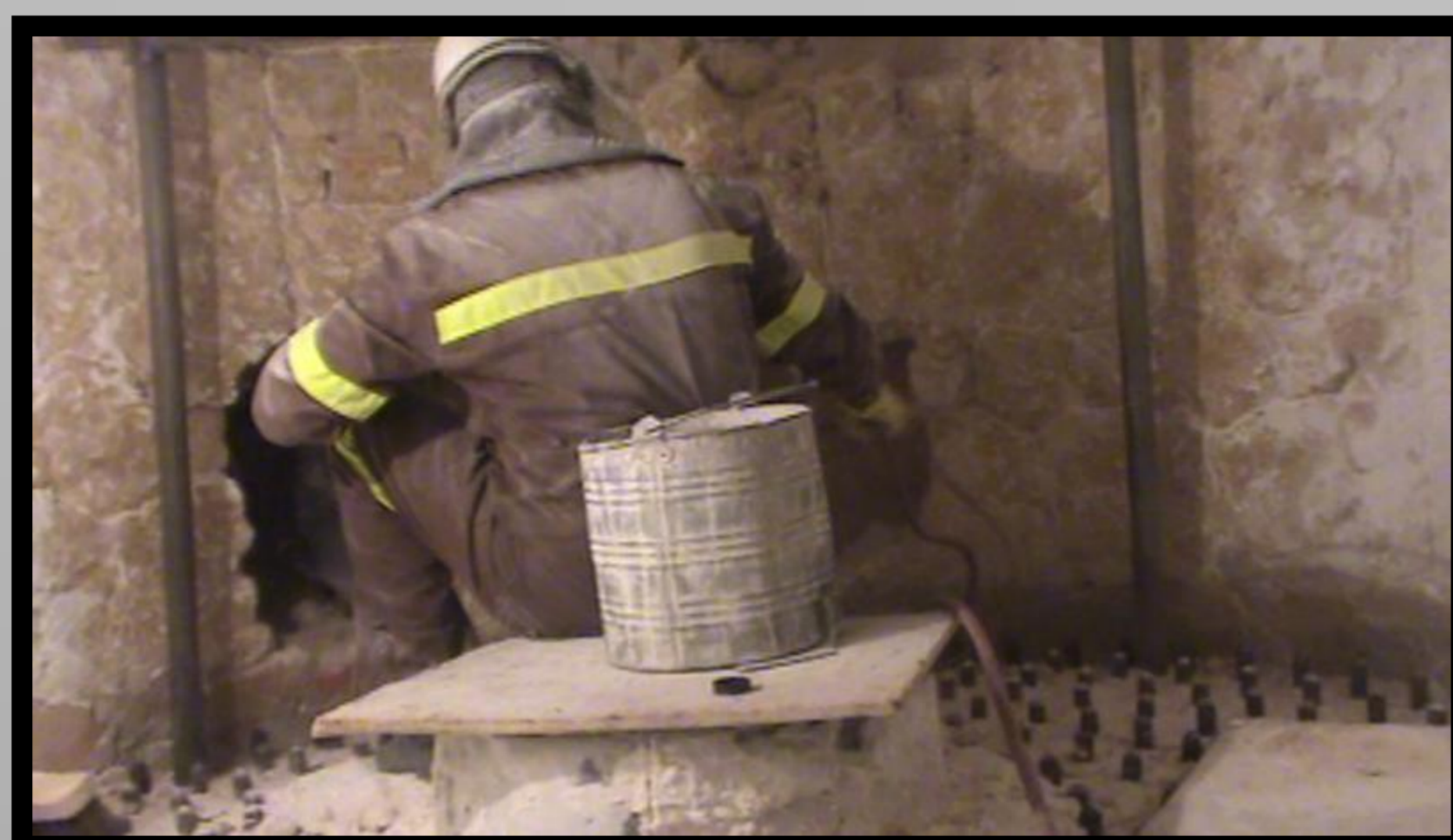
Fig # 4 – Necessário remoção somente área afetada
