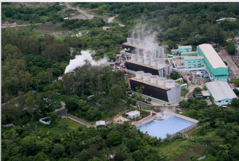
Central Geotérmica Ahuachapan
