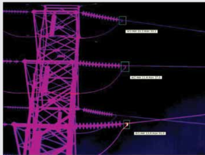
Imagem 02: Inspeção termográfica em rede de transmissão. Nesta aplicação é crucial a capacidade do sistema infravermelho em medir objetos pequenos a longas distâncias.
